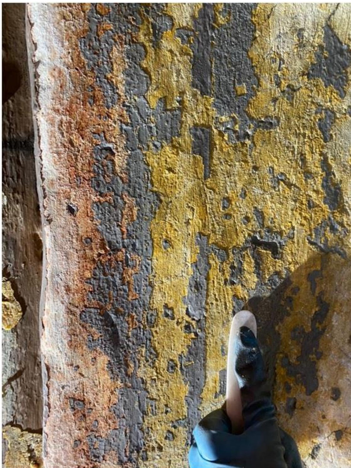
Ил. 11. Фрагмент орнаментальной росписи. В процессе укрепления. Размягчённые чешуйки красочного слоя приглаживались при помощи фторопластового шпателя. После укрепления копоть и масляная запись удалялись при помощи растворителя № 646, а на участках с плотным слоем масляной записи использовался гель для удаления масляной краски. После удаления записи на «разукреплённых» участках можно было провести повторное укрепление
