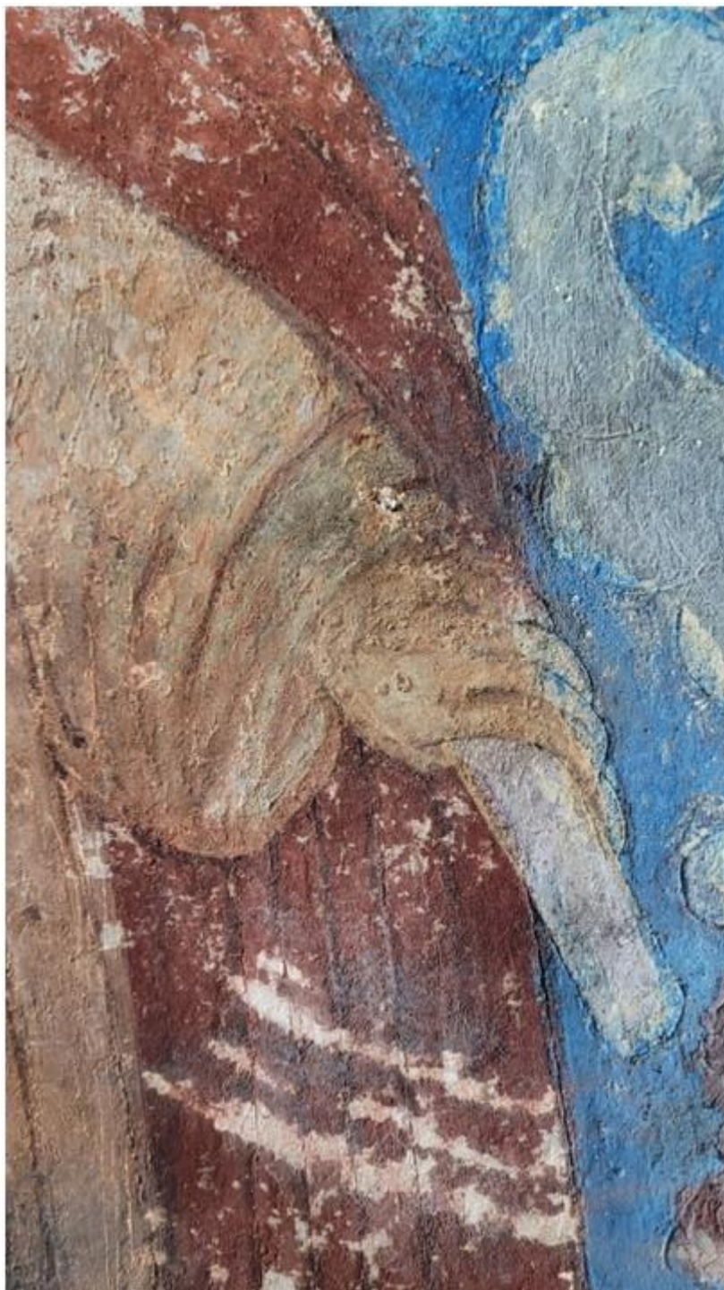
Ил. 5. Фрагмент фреско-темперной росписи конца XVII века из объёма северной галереи Спасо-Преображенского собора Новоспасского монастыря в Москве. До укрепления. Хорошо видны распыление, жёсткие шелушения и вспучивание красочного слоя от основы. Вся поверхность красочного слоя имеет пылевые загрязнения и копоть
