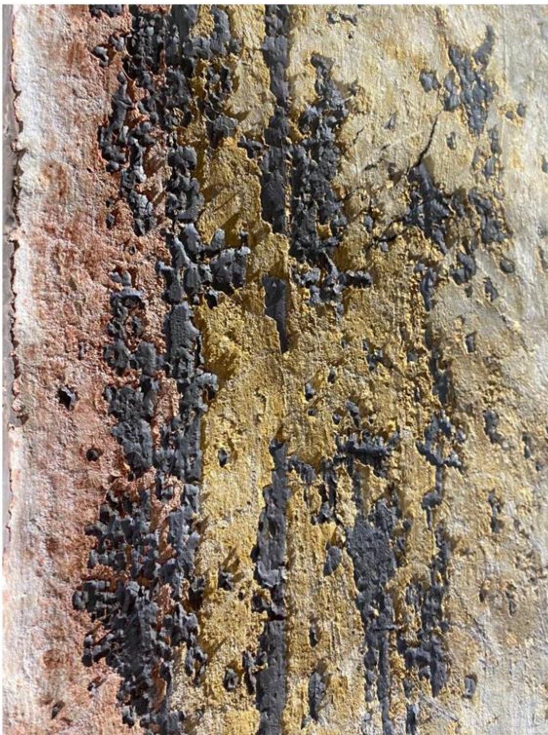
Ил. 10. Фрагмент орнаментальной росписи конца XVII века. Участок расположен в окнах центрального барабана Спасо-Преображенского собора Новоспасского монастыря в Москве. Распылённые остатки орнаментальной росписи покрашены плотным слоем масляной краски и имеют слой чёрной копоти на поверхности. Сначала жёсткие чешуи размягчались при помощи этилового или изопропилового спирта, затем участок напитывался клеевым раствором АК-211 3–5% концентрации. Выполнялось от 2 до 5 пропиток
