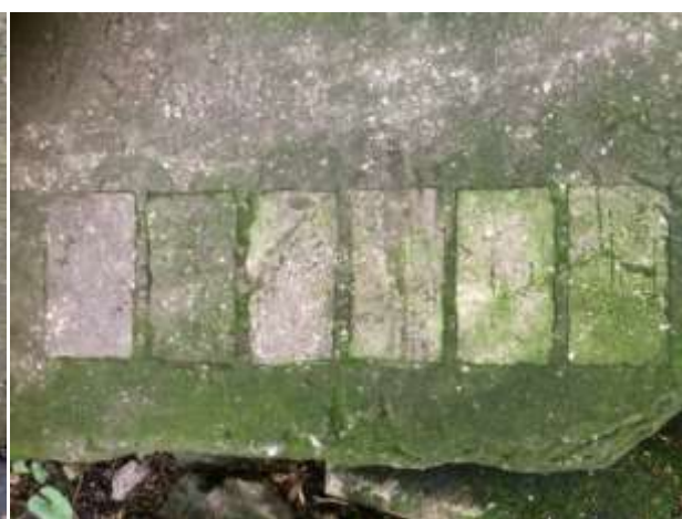
Рисунок 19. Тестовые площадки через 318 дня натуральных испытаний, 10.07.20
